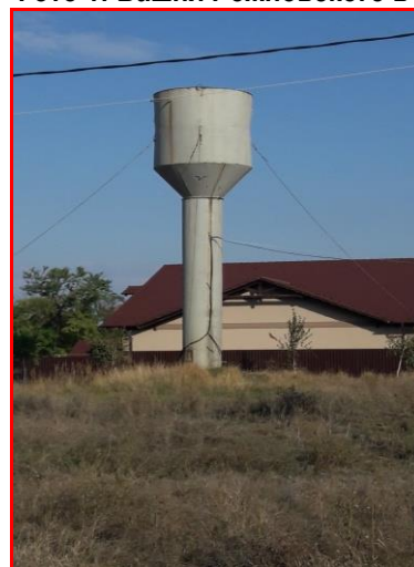
Фото 1: Башня Рожновского в мун. Комрат
